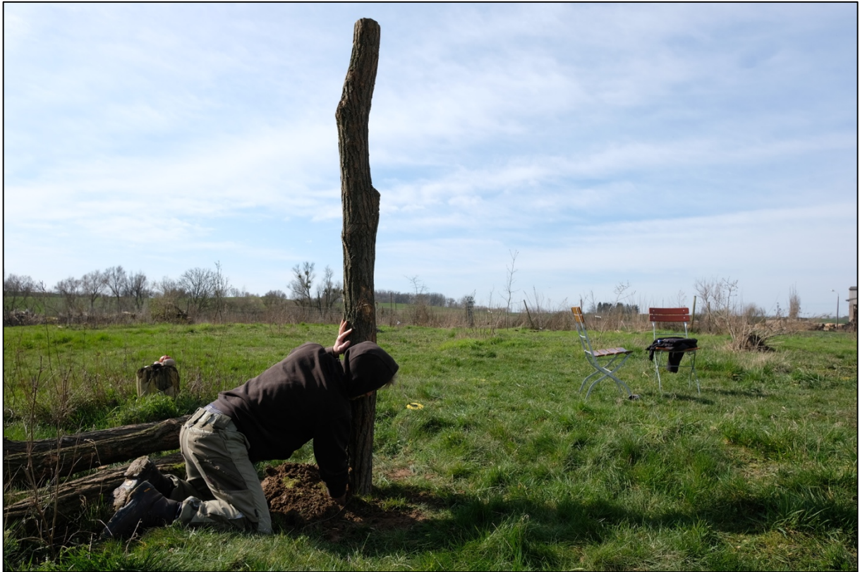
Abbildung 19 - Robinienpfähle werden versenkt (Eigene Darstellung)
