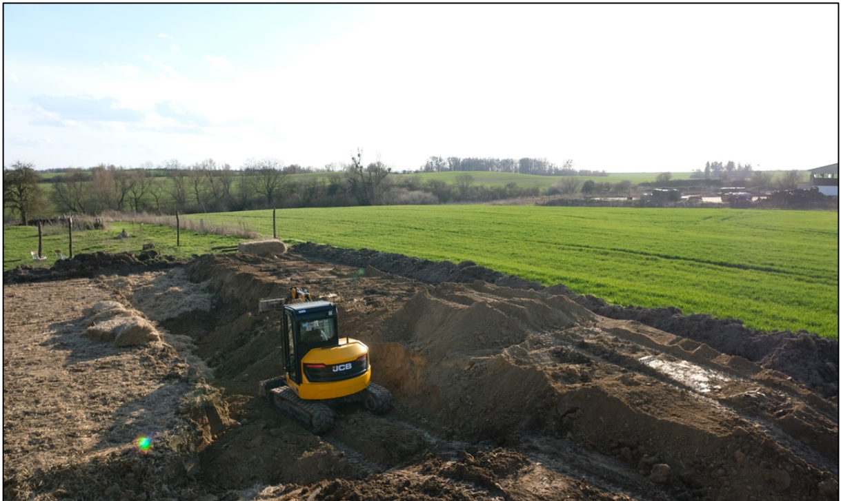
Abbildung 18 - Wiedereinbringung des Aushubs (Eigene Darstellung)
