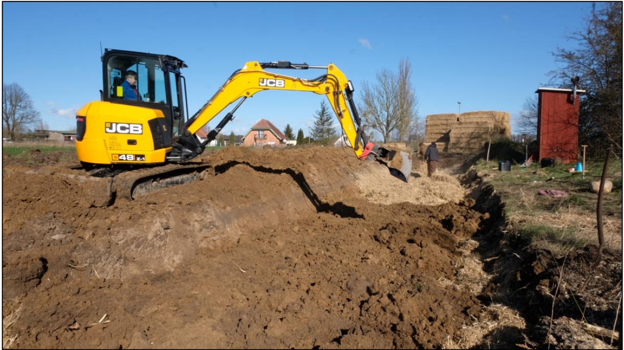
Abbildung 17 – Streifenweiser Aushub (Eigene Darstellung)
