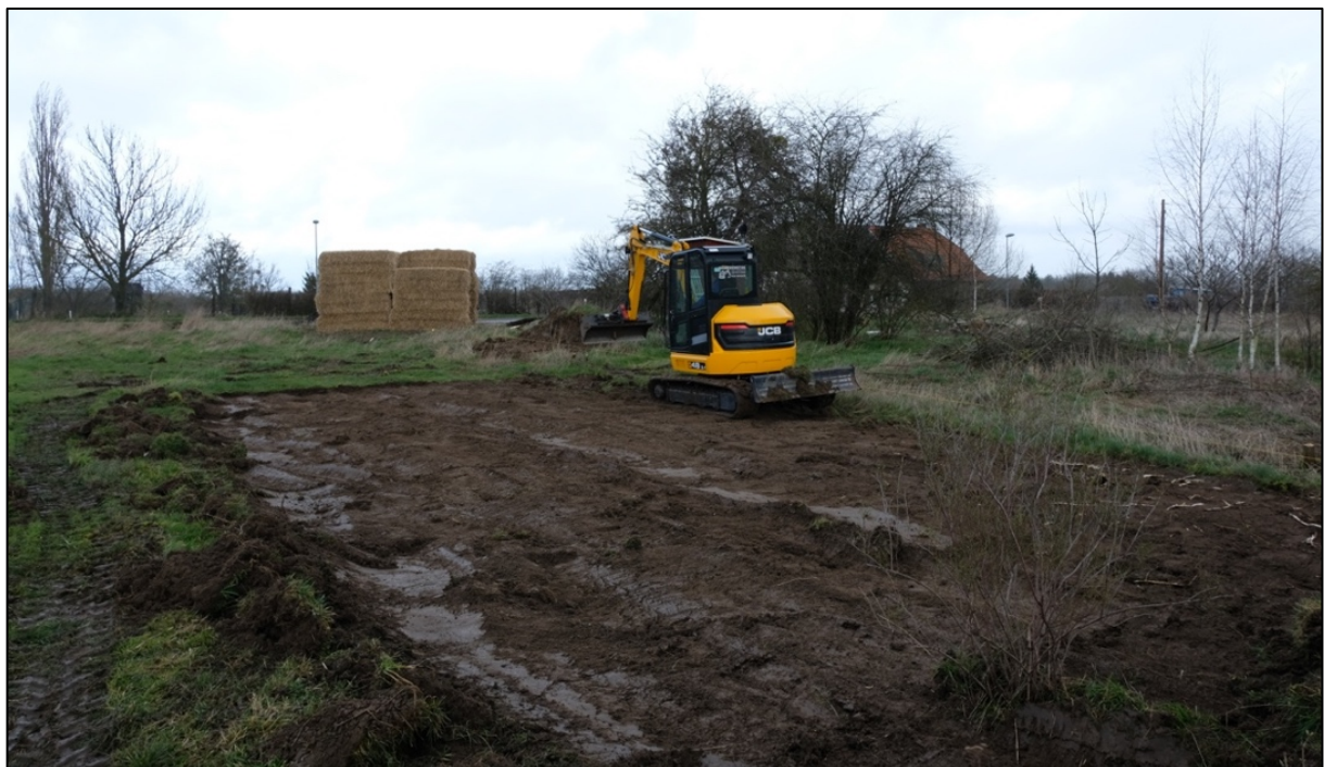
Abbildung 16 – Abziehen der Grassnarbe (Eigene Darstellung)
